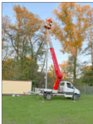
Für die Umrüstung der Lichtmasten war der Einsatz einer Hebebühne erforderlich.
